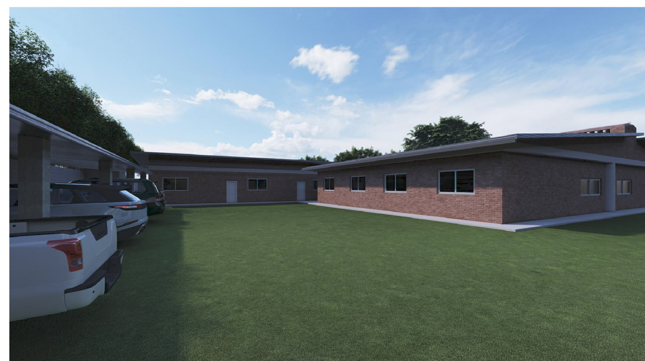
9 VISTA DO ESTACIONAMENTO
